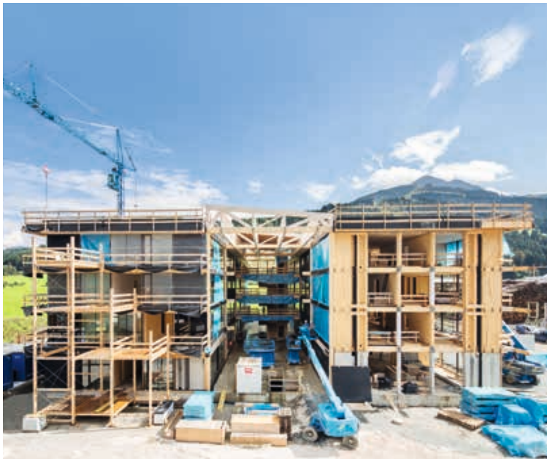
Новое здание головного офиса в Ст. Иоганне в Тироле (Австрия) в процессе строительства: административное здание из собственных материалов с весны 2015 года размещает более 250 сотрудников.
